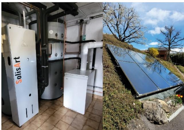
*Vortex Utility 18kW en relève de 8 capteurs solaires thermique, chauffage et ECS (Passy 74)*
