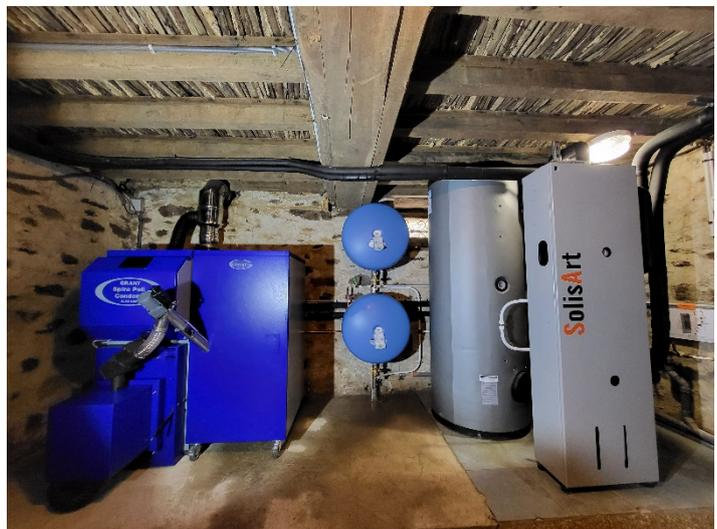
*Chaudière à granulés (montage ventouse horizontale) Spira Pell Etanche 9-33kW associée à un système solaire combiné composé de : 25m<sup>2</sup> de capteurs solaires thermiques + ballon ECS de 500L et ballon tampon de 1000L pour stocker l'énergie. Maison de 250m<sup>2</sup> (Mayenne)*
