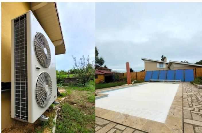
*Pompe à chaleur Aéroneo3 au R32 en relèvement de 6 capteurs solaires - alimente l'ECS, le chauffage et la piscine à Rives (38).*
